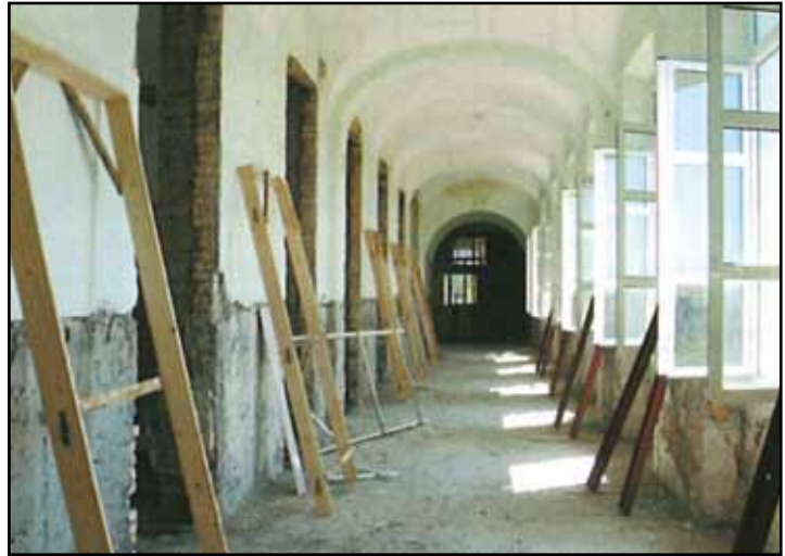
I lavori della ristrutturazione del S. Giuseppe
